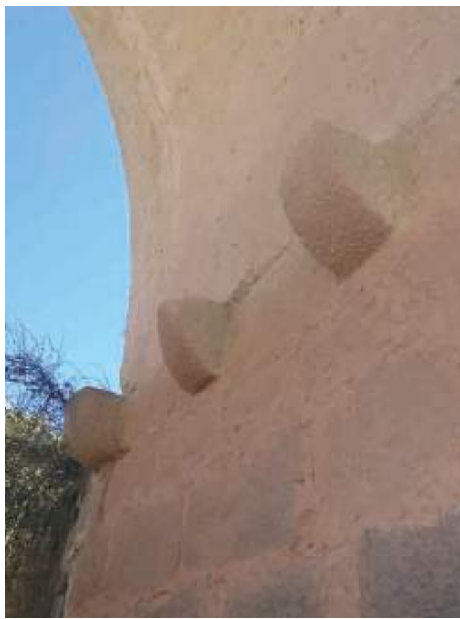
Fig. 3. Puente de san bartolome ó del diablo . Escorzo y detalle, ménsulas de apoyo. Foto: Víctor Hugo Limpías, 2012.
