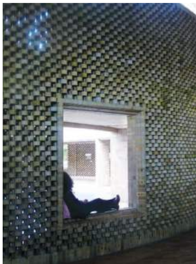
Fig. 7. Edificio de Posgrados Universidad Nacional, Bogotá. Arq. Rogelio Salmona. Foto: Ana María Carreira.
